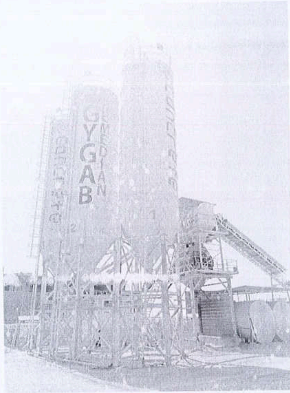
صورة رقم (١): منظر عام لمحطة الخط
